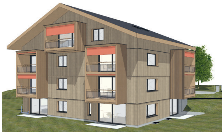
Ansicht von Südosten, Visualisierung: Fahrni Dällenbach Ewald Architekten, Steffisburg
